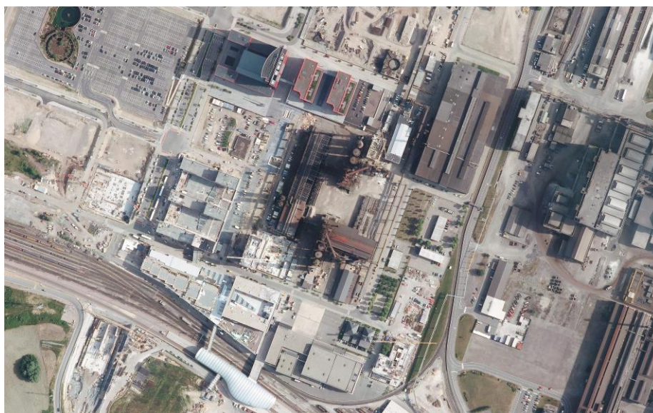
Le site de Belval (Source : Administration du Cadastre et de la Topographie, 2010)
